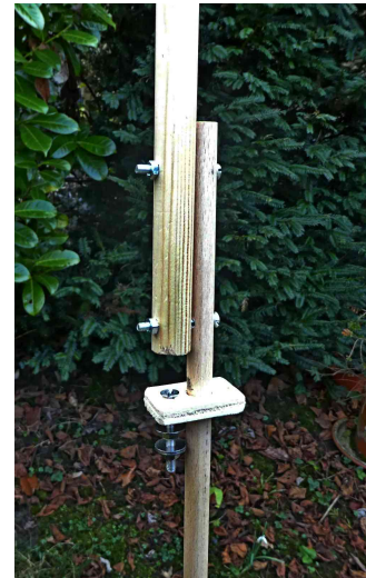
Bevestiging 18-12 mm en antennedraad
